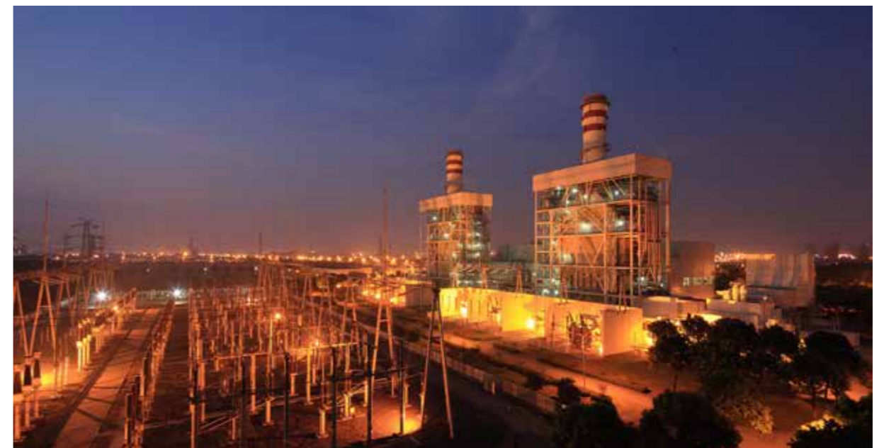
苏州蓝天燃气热电项目
